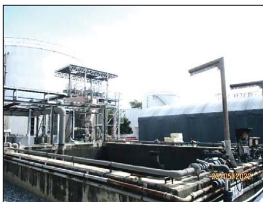
รูปที่ 2-11 การนำน้ำที่ผ่านการบำบัดแล้วมาใช้ใหม่ ระบบ Recovery basin
