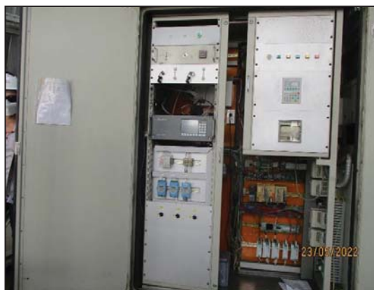
รูปที่ 2-1 เครื่องมือตรวจวัดคุณภาพอากาศแบบอัตโนมัติ (CEMs)
