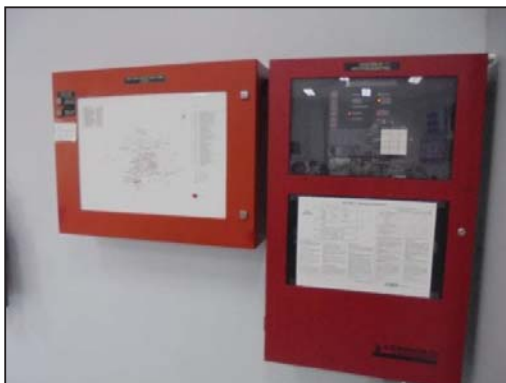
รูปที่ 2-21 ระบบสัญญาณไฟไหม้แบบ Online
